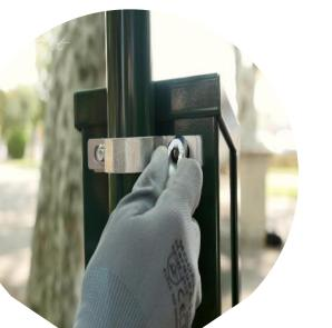
Installation du haut de mât et du distributeur sur le mât à l'aide des 3 colliers fournis
